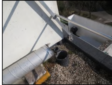
Photo N° 560 AMIANTE CIMENT TERRASSE Toiture Ventilation haute (Fibres-ciment)
